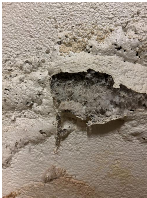
Mynd 7: Bólgur í yfirborði og úrfelling í steiptum útvegg í kjallara.
