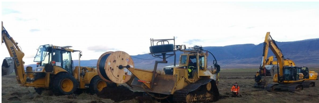
Mynd 17. Frá lagningu ljósleiðara í Skagafirði. Mynd, Sveitarfélagið Skagafjörður
